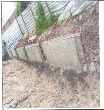
FOTO - 30 - Emboço paulista para paredes externas traço 1:2:9 - preparo manual - espessura 2,5 cm
