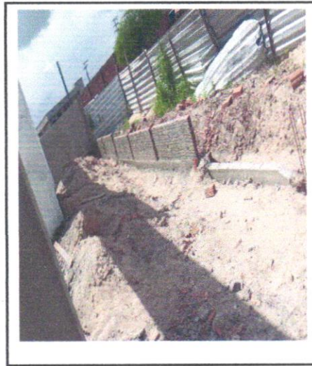
FOTO - 12 - ALVENARIA DE VEDAÇÃO DE BLOCOS CERÂMICOS FURADOS NA HORIZONTAL DE 9X19X29 CM (ESPESSURA 9 CM) E ARGAMASSA DE ASSENTAMENTO COM PREPARO MANUAL. AF_12/2021
