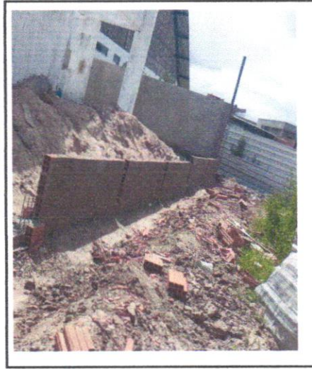
FOTO - 14 - CHAPISCO APLICADO EM ALVENARIAS E ESTRUTURAS DE CONCRETOINTERNAS, COM COLHER DE PEDREIRO. ARGAMASSA TRAÇO 1:3 COM PREPARO MANUAL. AF_10/2022
