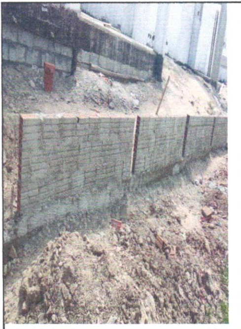
FOTO - 11 - CHAPISCO APLICADO EM ALVENARIAS E ESTRUTURAS DE CONCRETO INTERNAS, COM COLHER DE PEDREIRO. ARGAMASSA TRAÇO 1:3 COM PREPARO MANUAL. AF_10/2022
