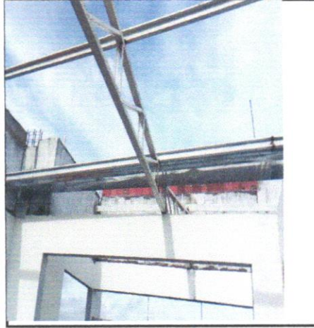
FOTO - 34 - CALHA EM CHAPA DE AÇO GALVANIZADO NÚMERO 24, DESENVOLVIMENTO DE 50 CM, INCLUSO TRANSPORTE VERTICAL.AF_07/2019
