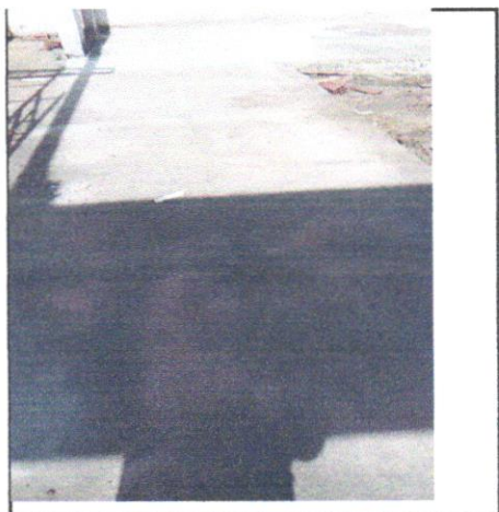
FOTO 37 - PISO CIMENTADO, TRAÇO 1:3 (CIMENTO E AREIA), ACABAMENTO LISO, ESPESSURA 2,0 CM, PREPARO MECÂNICO DA ARGAMASSA. AF_09/2020
