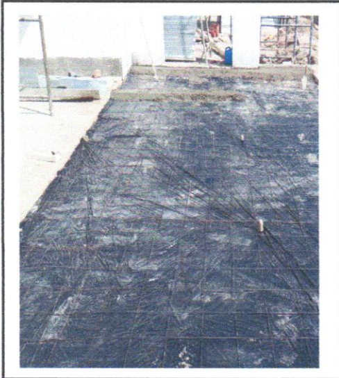
FOTO - 17 - PISO CIMENTADO, TRAÇO 1:3 (CIMENTO E AREIA), ACABAMENTO LISO, ESPESSURA 2,0 CM, PREPARO MECÂNICO DA ARGAMASSA. AF_09/2020
