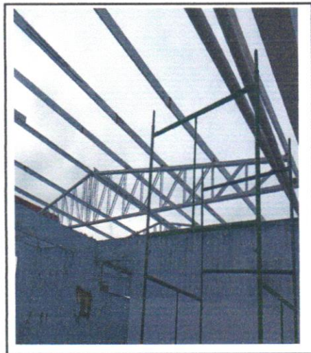
FOTO - 07 - TRAMA DE AÇO COMPOSTA POR TERÇAS PARA TELHADOS DE ATÉ 2 ÁGUAS PARA TELHA
