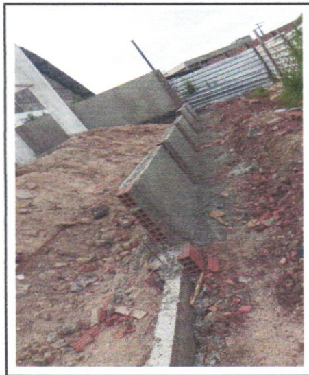
FOTO - 23 - EMBOÇO OU MASSA ÚNICA EM ARGAMASSA TRAÇO 1:2:8, PREPARO MECÂNICO
