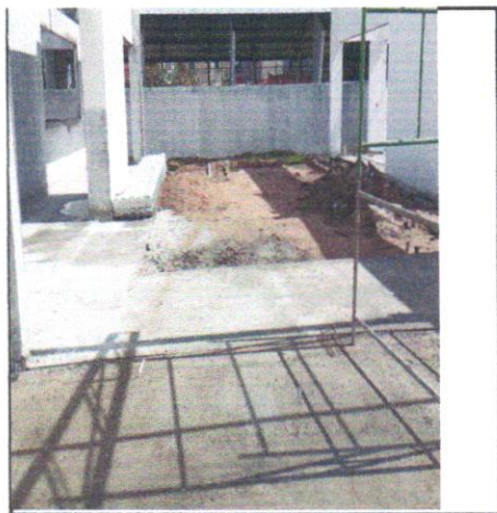
FOTO 39 - PISO CIMENTADO, TRAÇO 1:3 (CIMENTO E AREIA), ACABAMENTO LISO, ESPESSURA 2,0 CM, PREPARO MECÂNICO DA ARGAMASSA. AF_09/2020
