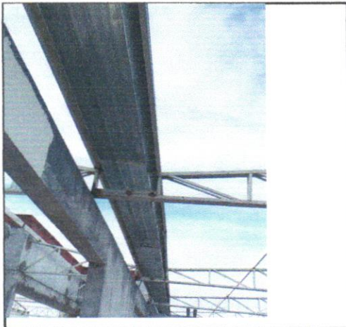
FOTO - 35 - CALHA EM CHAPA DE AÇO GALVANIZADO NÚMERO 24, DESENVOLVIMENTO DE 50 CM, INCLUSO TRANSPORTE VERTICAL.AF_07/2019
