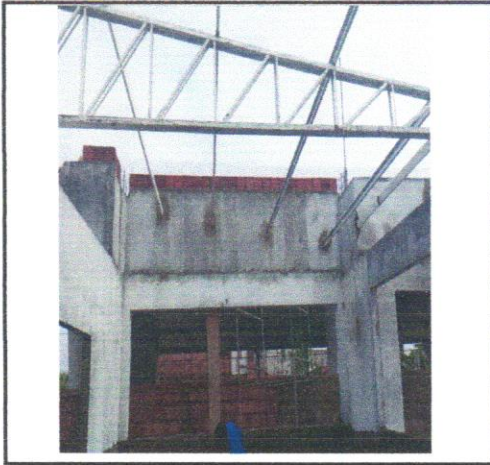
FOTO - 25 - TRAMA DE AÇO COMPOSTA POR TERÇAS PARA TELHADOS DE ATÉ 2 ÁGUAS PARA TELHA
