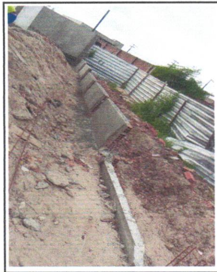
FOTO - 24 - Emboço paulista para paredes externas traço 1:2:9 - preparo manual - espessura 2,5 cm
