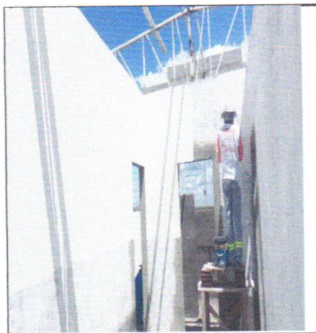
FOTO - 32 - APLICAÇÃO MANUAL DE MASSA ACRÍLICA
