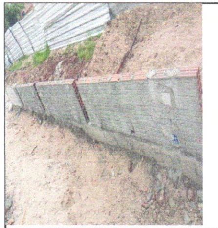
FOTO - 28 - CHAPISCO APLICADO EM ALVENARIAS E ESTRUTURAS
