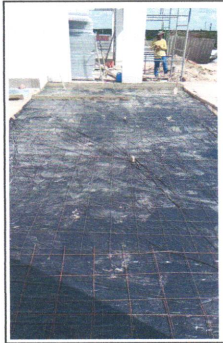
FOTO - 16 - PISO CIMENTADO, TRAÇO 1:3 (CIMENTO E AREIA), ACABAMENTO LISO, ESPESSURA 2,0 CM, PREPARO MECÂNICO DA ARGAMASSA. AF_09/2020
