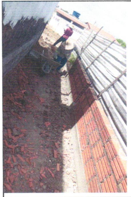
FOTO - 12 - ALVENARIA DE VEDAÇÃO DE BLOCOS CERÂMICOS FURADOS NA HORIZONTAL DE 9X19X29 CM (ESPESSURA 9 CM) E ARGAMASSA DE ASSENTAMENTO COM PREPARO MANUAL. AF_12/2021
