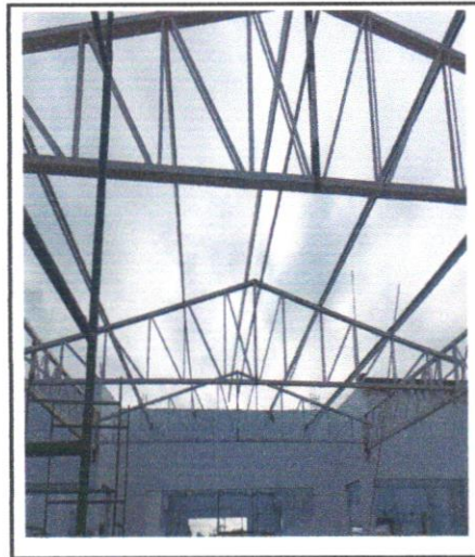
FOTO - 08 - TRAMA DE AÇO COMPOSTA POR TERÇAS PARA TELHADOS DE ATÉ 2 ÁGUAS PARA TELHA
