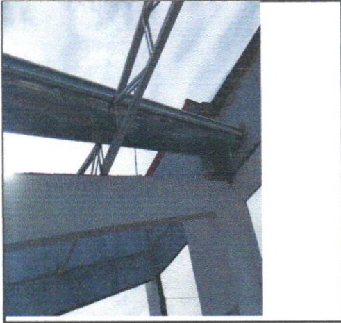
FOTO - 33 - CALHA EM CHAPA DE AÇO GALVANIZADO NÚMERO 24, DESENVOLVIMENTO DE 50 CM, INCLUSO TRANSPORTE VERTICAL.AF_07/2019
